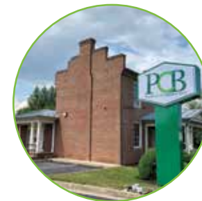
Bridgewater 317 N. Main Street
